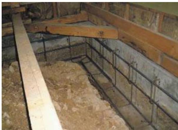
左写真は屋内側に鉄筋コンクリート基礎を打ち増しした補強例
