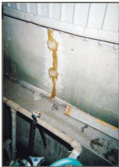
放置しておくとも、内部の鉄筋が錆びて、コンクリートを壊す恐れがあるので、基礎のひび割れ部分に、**エポキシ樹脂等**を注入して補修します。
