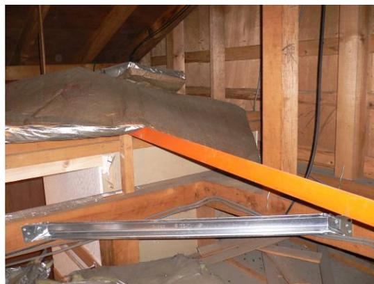
火打ち金物による補強例
